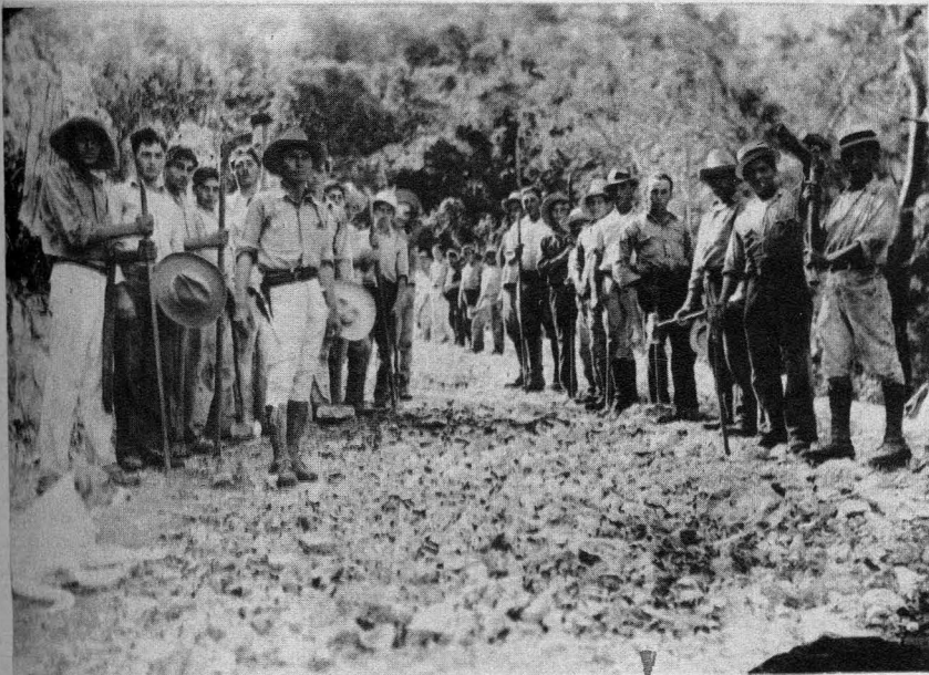
MAYAJIGUA.—Obreros que construyen la carretera de Mayajigua a Yaguajay, a cuya obra ha contribuido el doctor Germán Wolter del Río.
