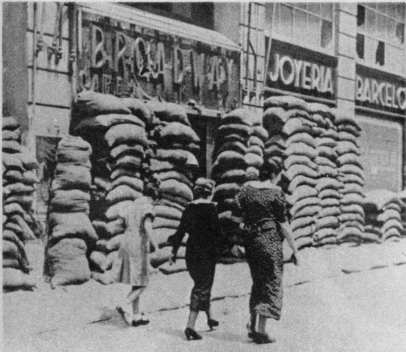
Madrid: las tiendas de la Gran Vía fortificadas con sacos terreros contra los cascos de granada.
